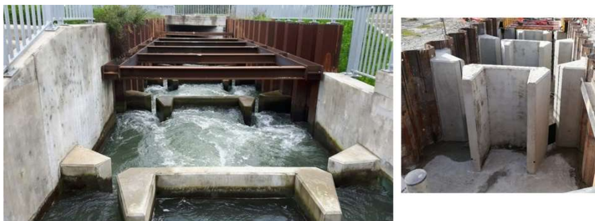
Figure 2 : Principe passe à poissons à double fentes à bassins successifs (Source : CNR)
